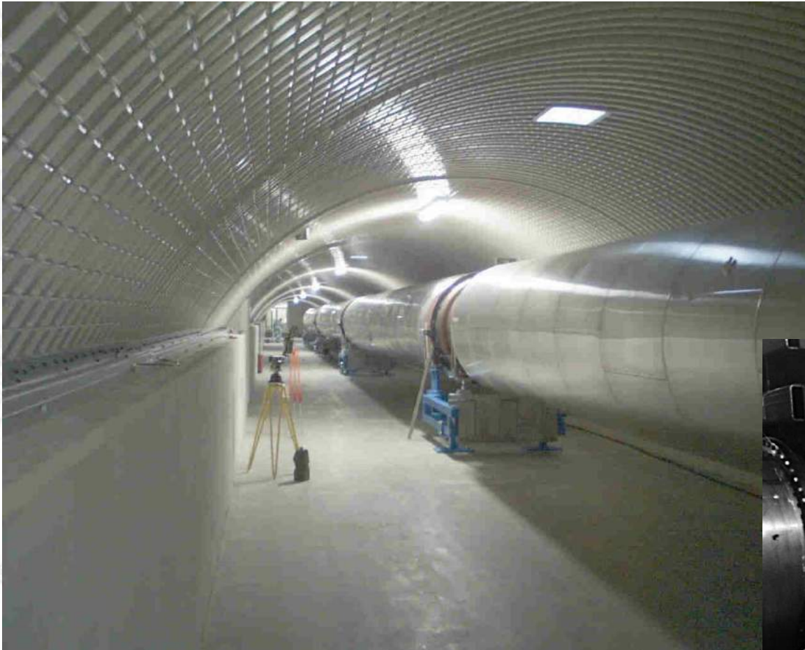
Trappole criogeniche all'azoto liquido
